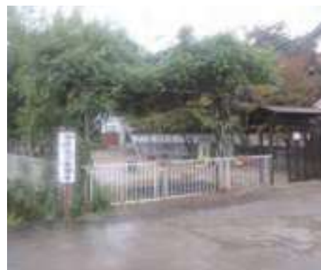
<施設外観(正面入口)>
