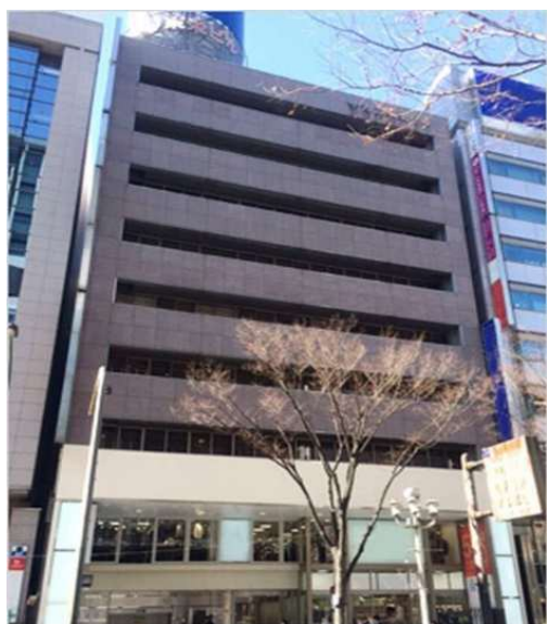
「サカエ東栄ビル」外観
